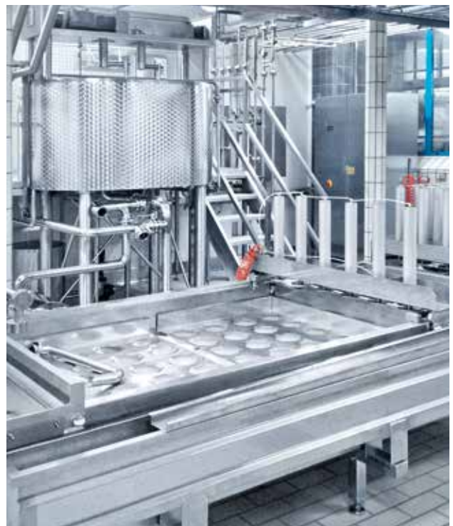
Käsefertiger mit Einschwemmpresse
