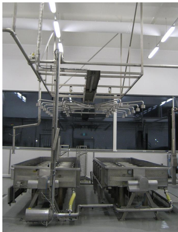
Einbindung der vorhandenen Pressen in die neue Produktion
