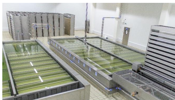
Tiefensalzbad mit automatischer Be- und Entladestation
