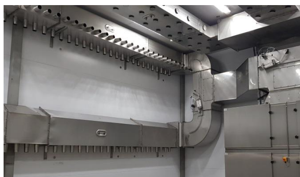
4-канальная система для оптимальной подачи воздуха
